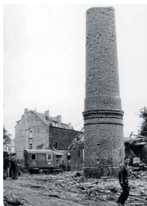
Der Schornstein an der Petersilienstraße wurde 1963 abgebrochen.
