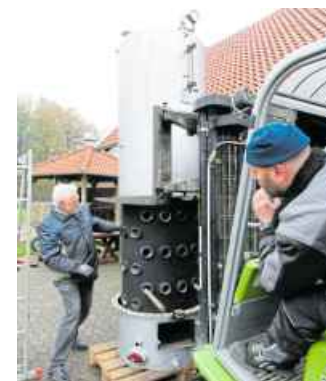
Staplerfahrer Daniel Siemens lässt den oberen Kesselmantel ab – ganz vorsichtig.
