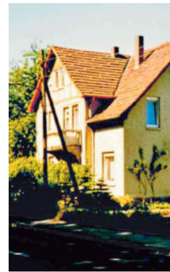
Das Haus Bündler Straße 59 kurz vor dem Abriss.
