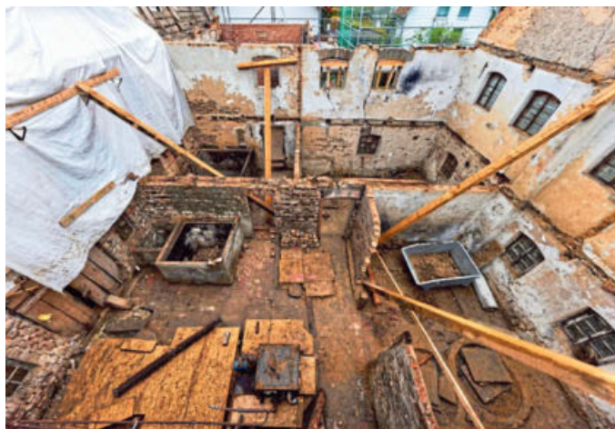
Das Dach ist weg, die Restaurierung der Lohgerberei in Enger nimmt Fahrt auf. Sie stammt von 1740. Deutlich erkennbar sind die Umrisse der Gruben. Hierin wurden die Tierhäute mit Hilfe gemahlener Eichenrinde, der Lohe, gegerbt. Das Gerbereimuseum wächst um ein hochspannendes Kapitel.
