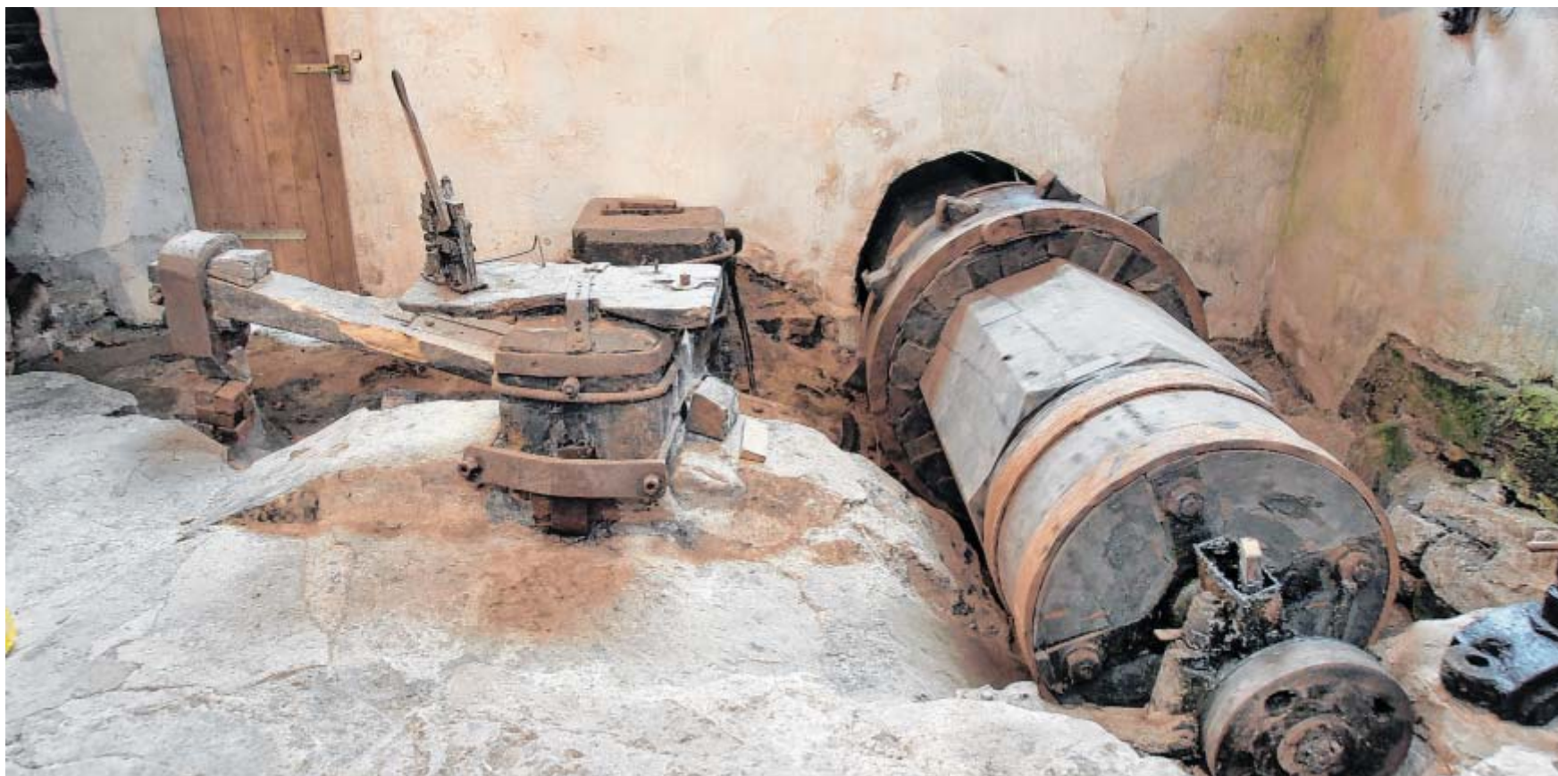
Verborgten im Keller: Der Schwanzhammer ist ein technisches Denkmal ersten Ranges. Schon 1963 hat ihn der Herforder Helmut Richter genau beschrieben und gezeichnet. Von ihm wissen wir: 8 PS leistete das Wasserrad, 195 Mal schlug der Hammer zu – in der Minute. Ein Powergerät.
