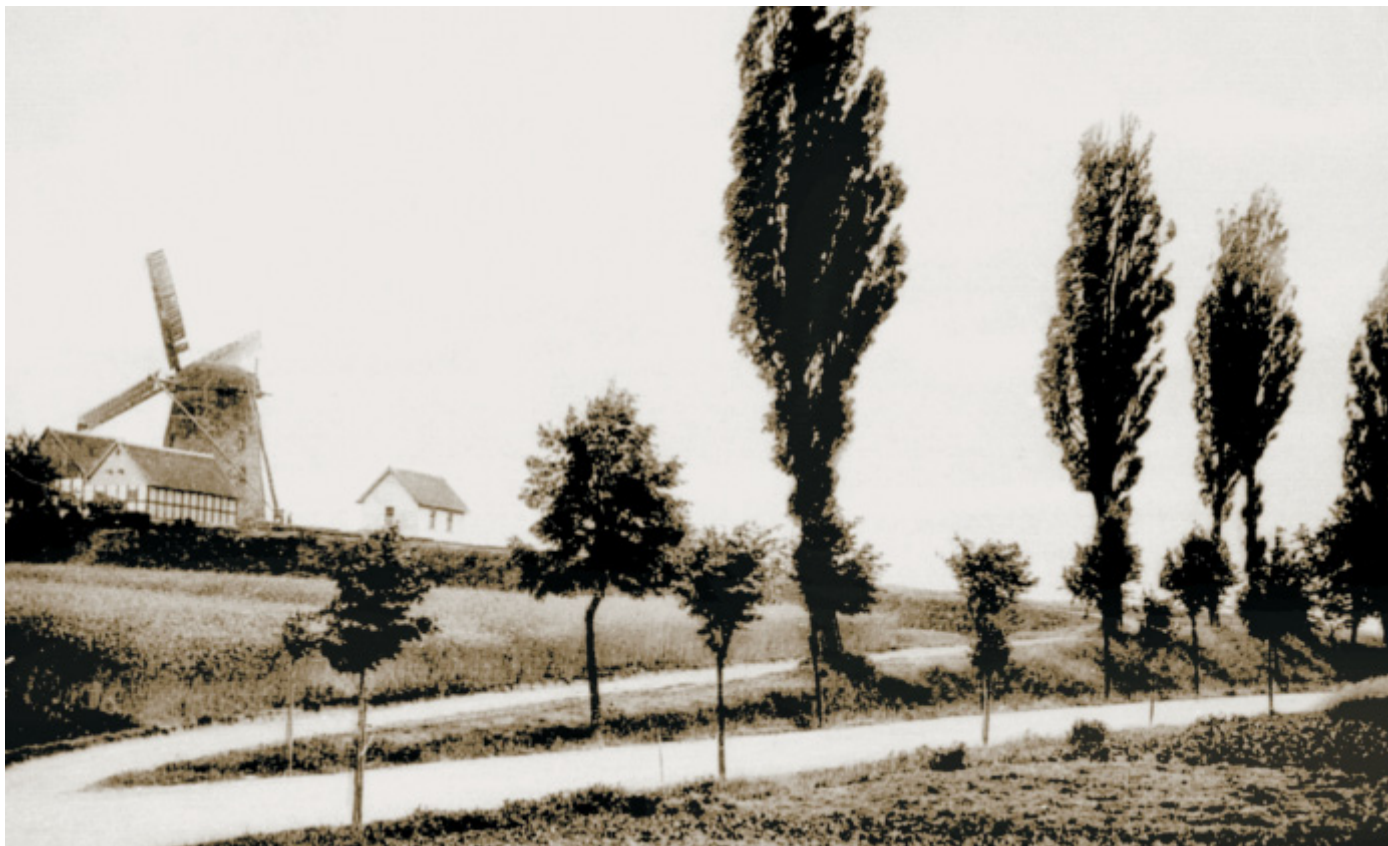
Hohe Böschung: Die alte Abbaukante der Sandgrube am Liesberg ist gut zu erkennen. Das Foto entstand vor 1923.
