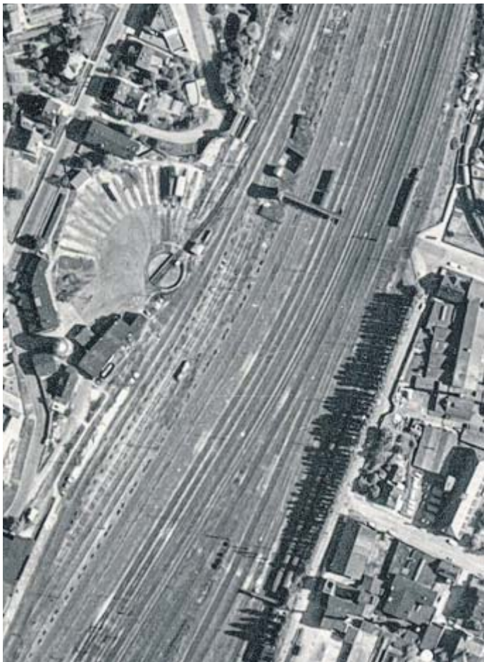
Drehscheibe: Auf dem Luftbild von 1962 ist die Drehscheibe am Herforder Güterbahnhof gleich hinter der Bahnunterführung der Sophienstraße noch vorhanden.
