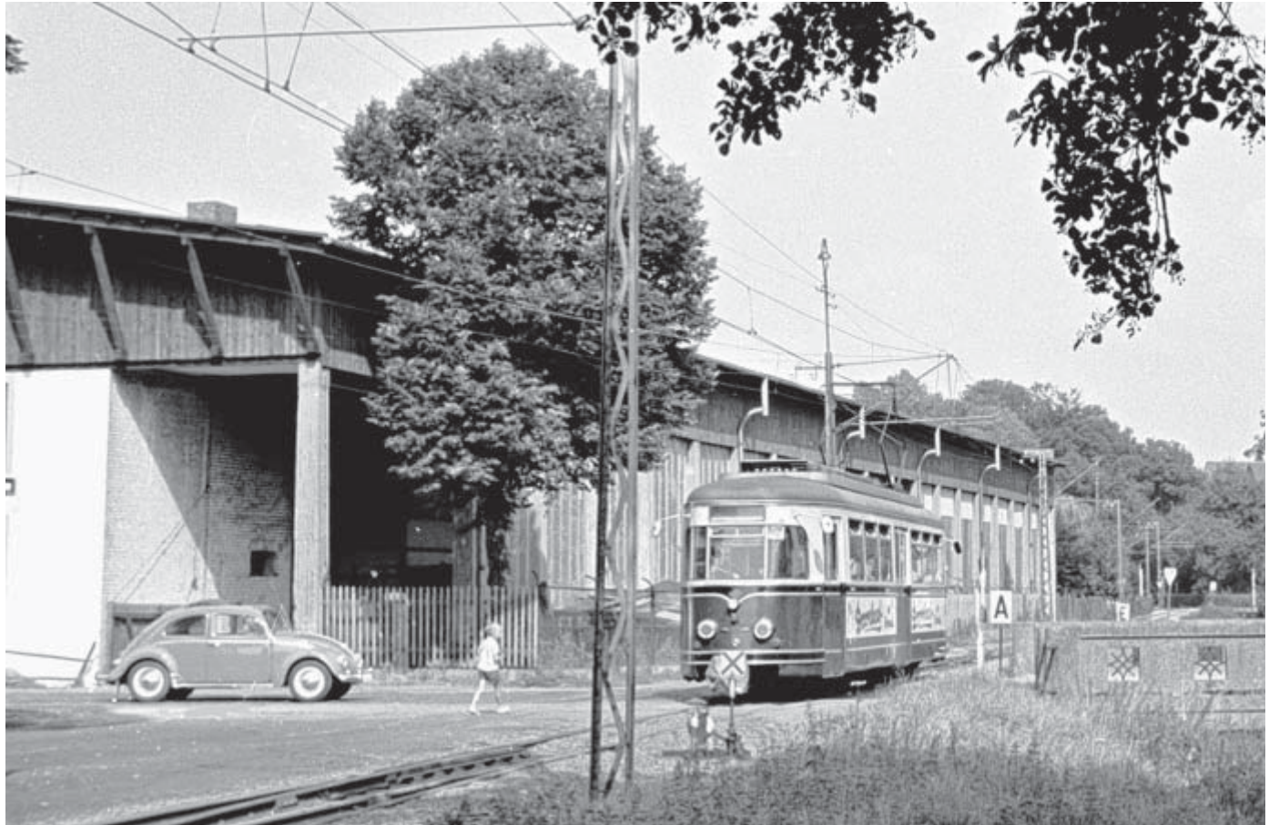
An Heckwerths Halle: In Enger war sie als erste freitragende Nagelbinderhalle dieser Größenordnung in Deutschland in den 1950er-Jahren gebaut worden; erst kürzlich wurde sie abgerissen. Hier fährt (das Foto entstand 1963) gerade ein Großraumtriebswagen der Kleinbahn vorbei.
