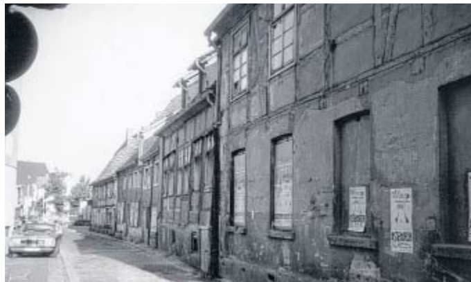
Kurz vor dem Abriss: Die Budenzeile an der Tribenstraße 1978 bietet ein Bild des Verfalls. Links im Bild ist das etwa zehn Jahre zuvor gebaute neue Altstädter Parkhaus zu erkennen.
