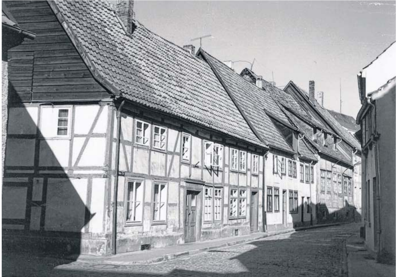
Stadtteil der kleinen Leute: Die Tribenstraße in den 50er-Jahren, eine enge Gasse in der Herforder Altstadt mit aus heutiger Sicht pittoreskem Charme. 20 Jahre später waren die Häuser verfallen, niemand wollte dort wohnen.
