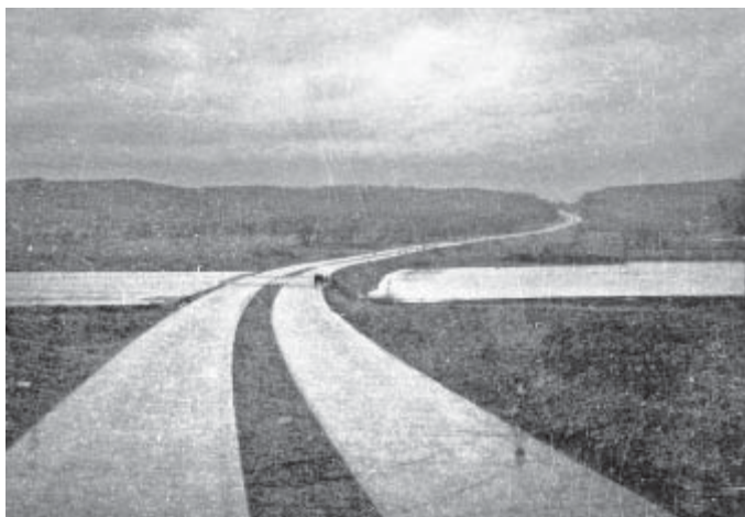
Autobahn mit Werrebrücke: Gesehen von der Zubringerstraße am Ahmser Krug.
