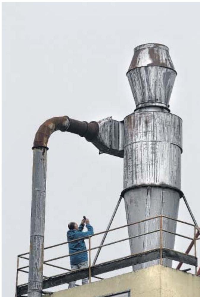
**Raffiniert konstruiert:** Zyklone bestehen aus je einem zylindrischen und einem kegelförmigen Gehäuseteil aus Blech und sind innen hohl. Nur ganz feine Stäube gelangen ins Freie, Späne fallen in den Bunker.
