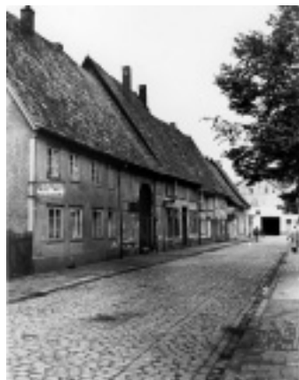
Weg zum Badehaus: Vor diesem Haus (vorn) an der Petersilienstraße ging es links zur Mikwe.
