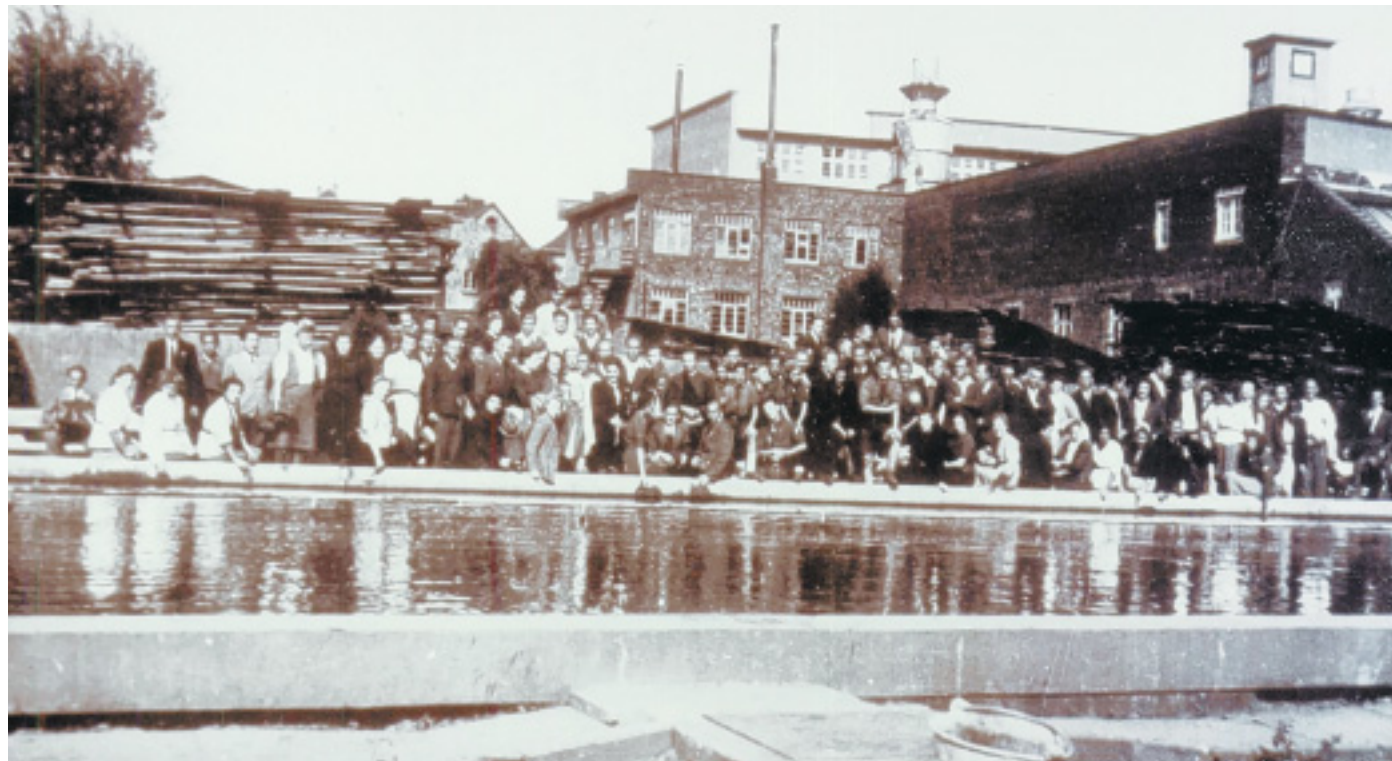
Nach der Befreiung im April 1945: Die polnischen Zwangsarbeiter formieren sich auf dem Gelände der Beka-Möbelwerke zu einem Gruppenfoto. Dieses Foto befand sich in den Prozessakten in Polen.
