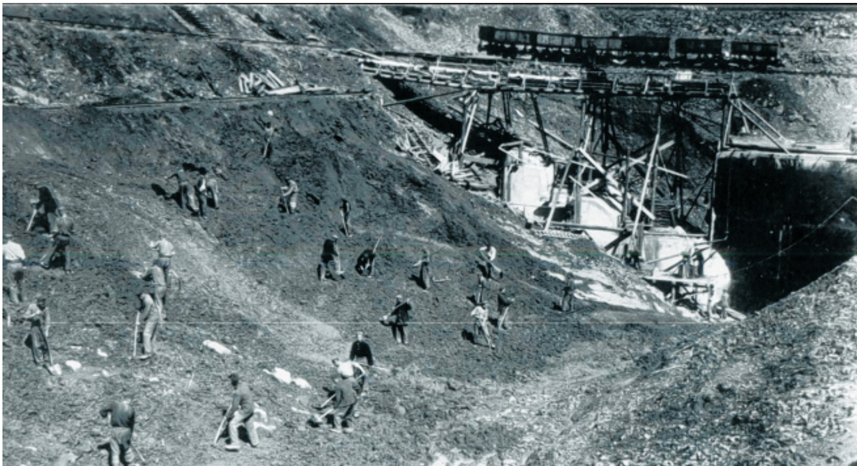
Staudamm im Sauerland: Insassen des „Arbeiterziehungslagers“ Hunswinkel waren beim Bau der Staumauer der Versetalsperre eingesetzt. Einer von ihnen war Efim Gorgol.
